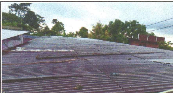
FOTO 3: Sustitución de lámina, por lámina troquelada aluzinc calibre 26 EN AULAS
