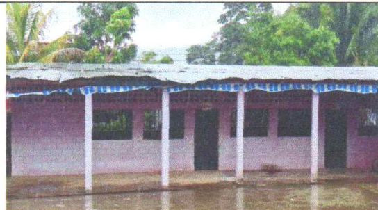
FOTO 6: Pintura en muros exteriores e interiores
