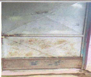
FOTO 5: Sustitución de puerta EN AULAS
