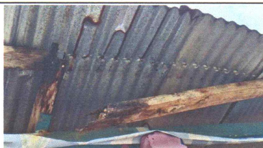
FOTO 4: Sustitución de estructura de soporte de madera, por metal EN AULAS
