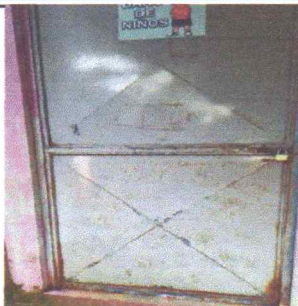
FOTO 1: Mantenimiento a estructura (lijado, cambio de tubo, cepillado, sujeciones, aplicación de pintura) PUERTA EN BAÑOS
